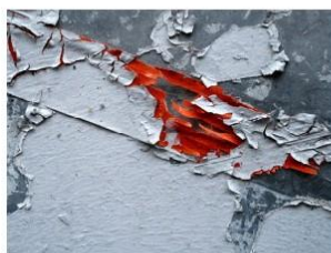
Exemples de revêtements dégradés représentant un risque pour la santé. Plaquette d'informations disponible sur : http://www.sante-sports.gouv.fr
